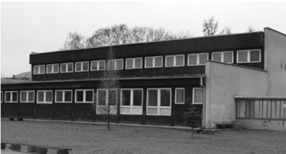
Staručká telocvičňa pri Základnej škole v Beluši doslúžila. Dva roky je zavretá. Obec ju chce zbúrať a na jej mieste postaviť novú. FOTO: Milan Podmaník
